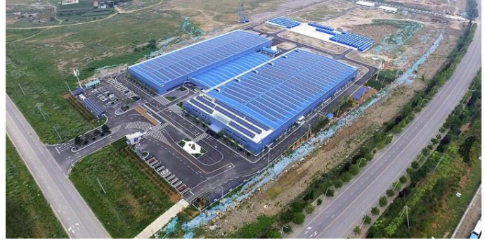
Hệ thống VRFB 100MW / 400 MWh ở thành phố Đại Liên, tỉnh Liêu Ninh, Trung Quốc
