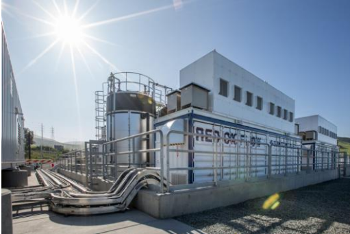
Dự án VRFB 2MW/8MWh ở California do Sumitomo Electric Industries (SEI) của Nhật Bản cung cấp, năm 2018.
